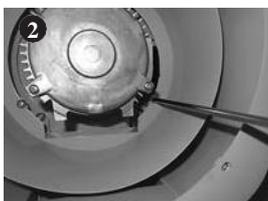
Desatornille el cilindro exterior.
